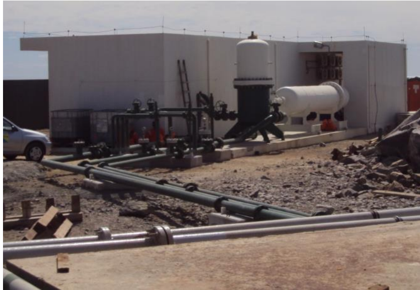
Figura 1.8: Sistema hidráulico do conversor de energia das ondas desenvolvido pela COPPE/UFRJ .
