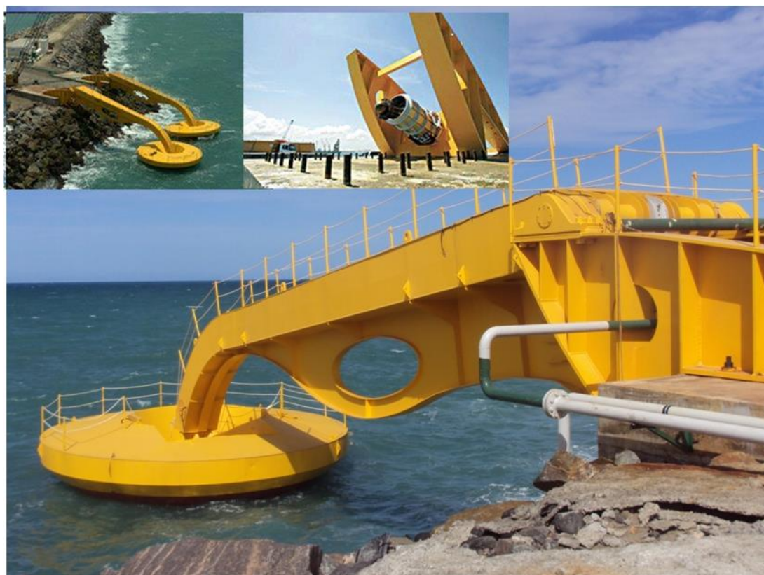
Figura 1.7: Conversor de energia das ondas desenvolvido pela COPPE/UFRJ – Flutuadores, vista geral e bomba hidráulica.
