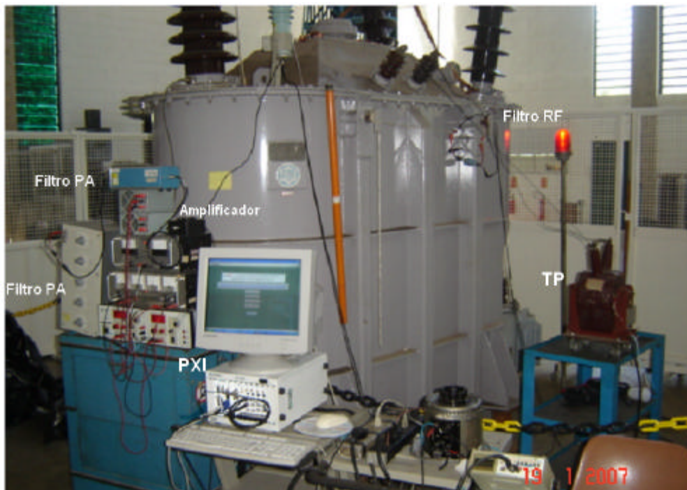
Figura 8.9 – Arranjo para teste do sistema de medição em equipamento energizado.
